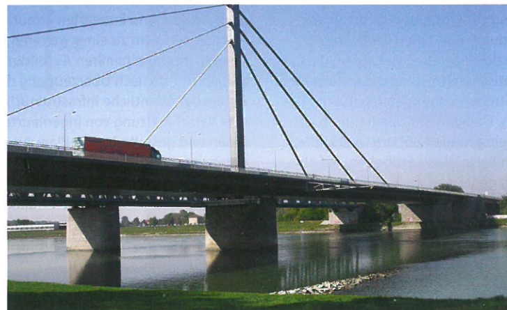
1 Rheinbrücke Maxau (noch) vor der Ertüchtigung © Regierungspräsidium Karlsruhe
