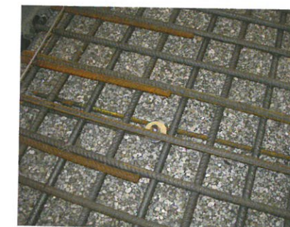
3 Vorbereitete Bewehrungslage © Regierungspräsidium Karlsruhe
