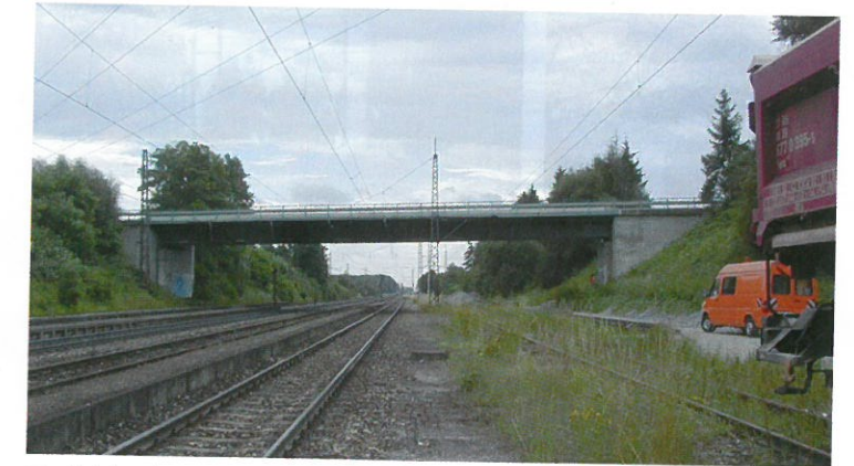
2 Bahnbrücke Beimerstetten nördlich von Ulm © Regierungspräsidium Karlsruhe
