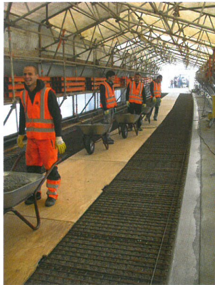
5 Anlieferung des hochfesten Betons © Regierungspräsidium Karlsruhe
