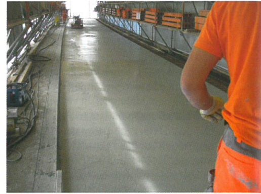
7 Betonierabschnitt nach Fertigstellung © Regierungspräsidium Karlsruhe
